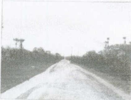
**Foto 16** – trecho em revestimento primário, com interferências (rede elétrica na margem da via).
