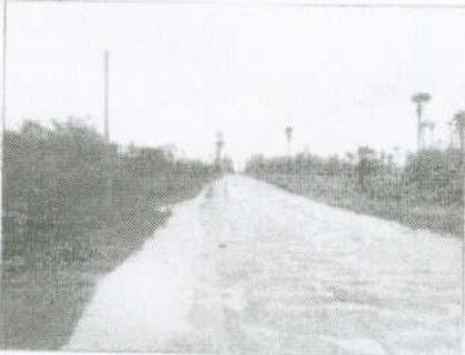
**Foto 15** – trecho em revestimento primário com acumulo de água na margem da via, no período chuvoso.
